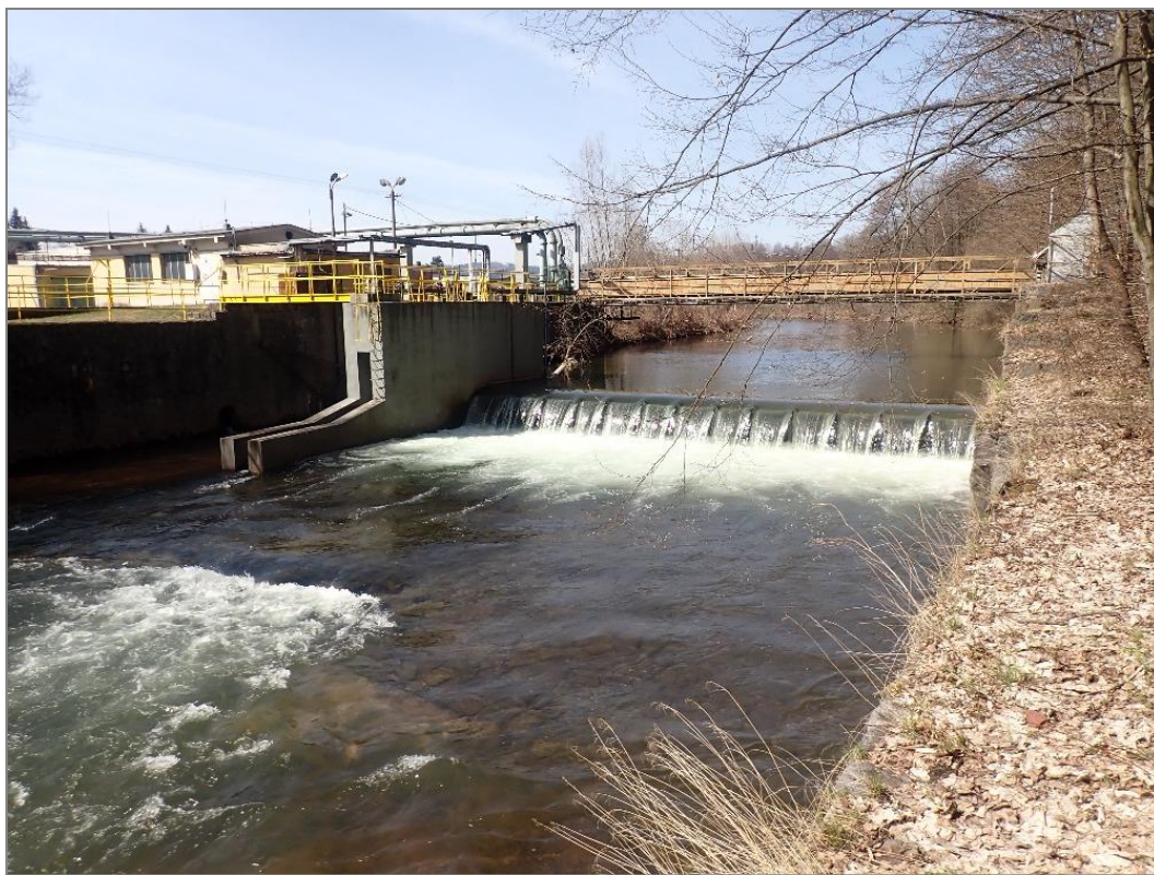
Jez vodní elektrárny Poříčí na řece Úpě v říčním kilometru 44,600
